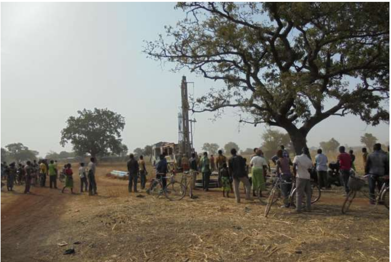
Début des travaux de forage dans un village où les habitants ont tant besoin d'eau potable
